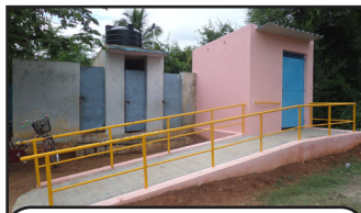
Les toilettes accessibles.
